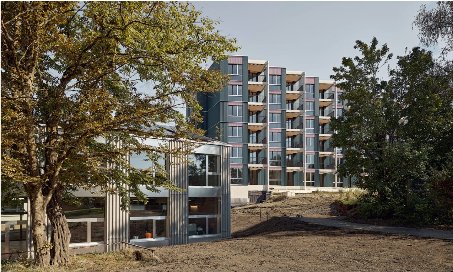
Blick aus Südwesten auf den Neubau Rehbühl mit dem Erweiterungsbau der Berufswahlschule Uster links im Bild.
